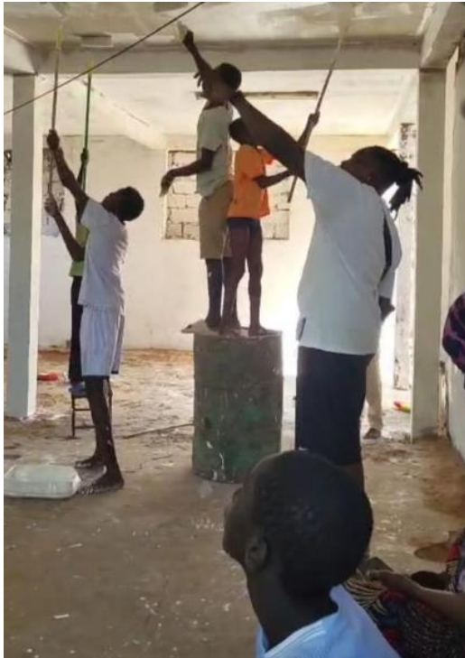
Asociación New di Doley, colaborando con pintura para las clases que se están construyendo en la aldea de Louga que pertenece a la provincia de Dakar en Senegal.
